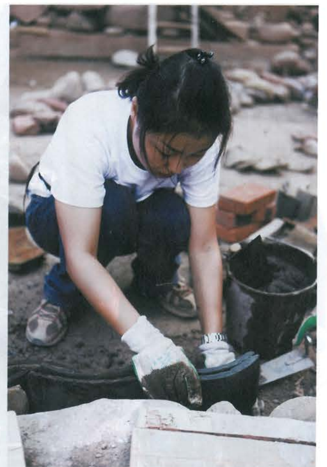
2009年7月，萬麗在四川馬鞍橋村村民活動中心鋪地
